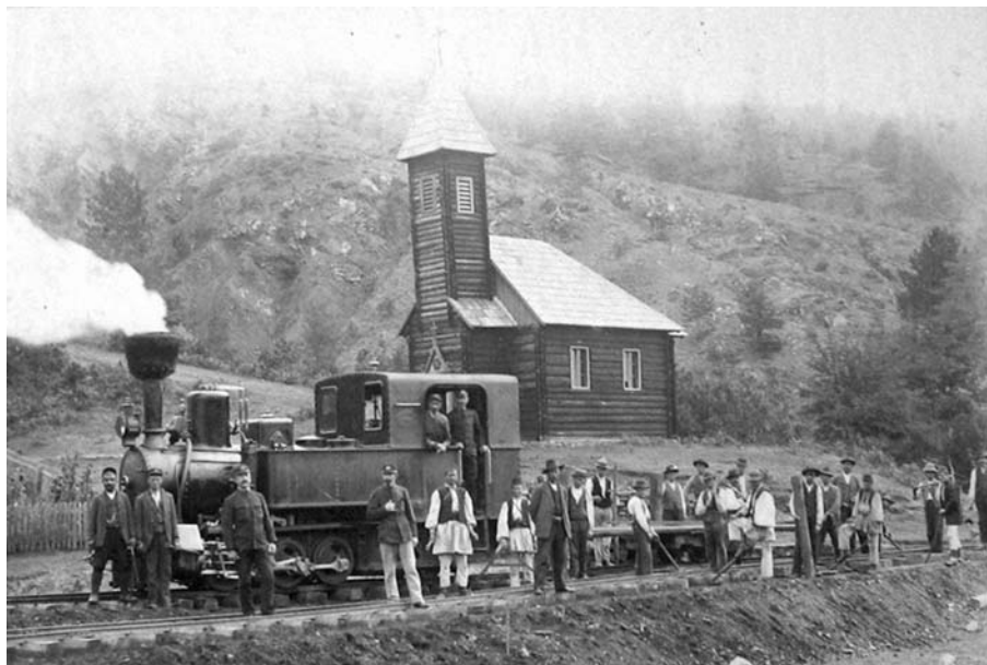
Католичка црква у Прибинићу (изграђена 1900)
